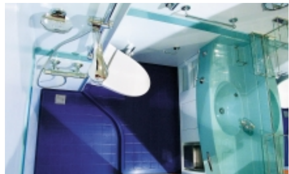
Komposiiteista rakennettu kylpyhuone on kevyt ja se voidaan asentaa laivaan nopeasti.
