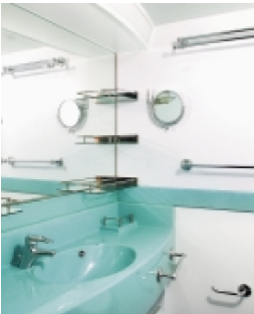
Risteilijän kylpyhuone on rakennettu saumattomasta laminaattirakenteesta. Rakenne on IMO-hyväksytty.
